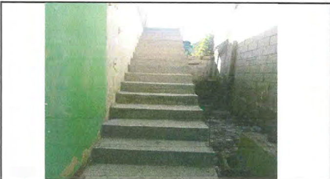
Foto 3: Remanente, construcción de gradas
