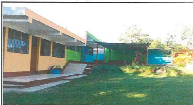
Foto 4: Pintura en paredes
