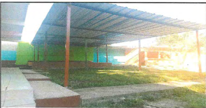
Foto 5: Reparación de techo en escenario
