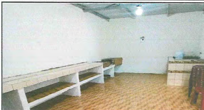
Foto 2: Remozamiento en cocina
